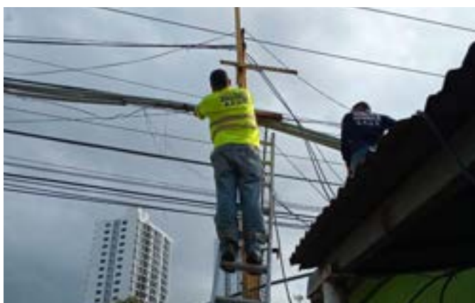
Instalación de luminarias en Zona No.2 - Carrasquilla
