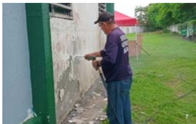
Limpieza de los Edificios de Zona No.1 – INADEH, con Hidro-lavadora.
