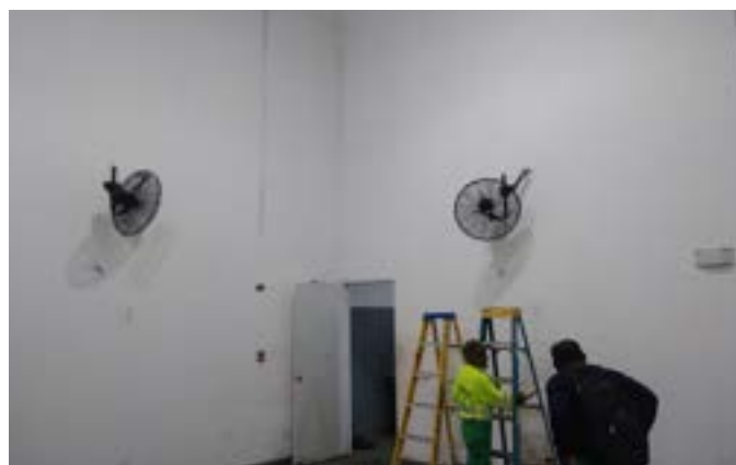
Instalación de abanicos en Zona No.1 - INADEH
