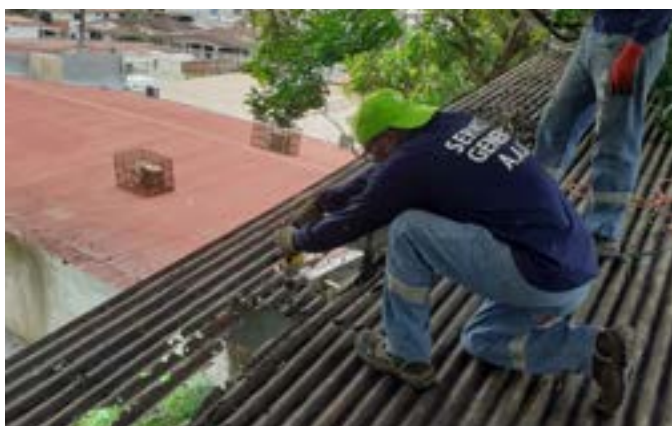
Limpieza de techo Zona 2 - Carrasquilla
