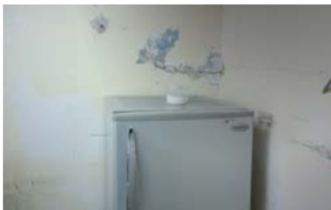
Reparación de paredes en Altamira
