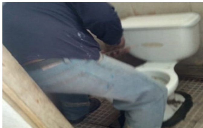
Instalación de Inodoros
