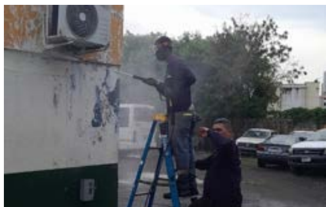
Limpieza de los edificios de Zona No.1 – INADEH, con Hidro Lavadoras
