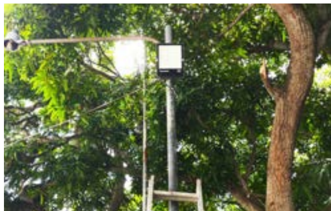
Instalación de lámparas en Zona No.2 - Carrasquilla
