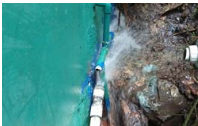
Reparación de tubería de \frac{3}{4} " de la bomba de succión que abastece la oficina de Patacón
