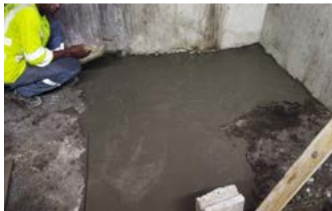
Reparación del piso del Restaurante
