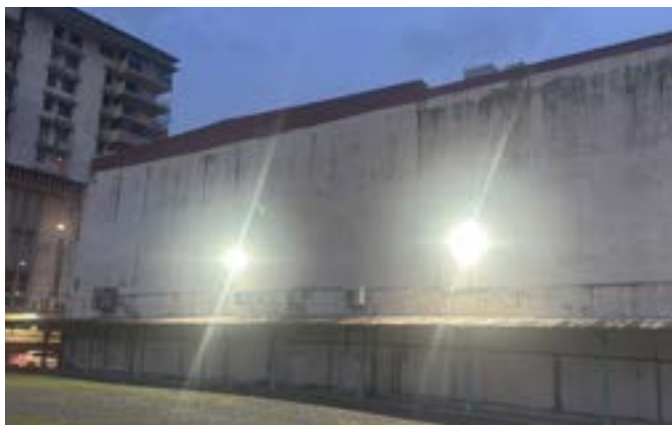
Iluminación de los estacionamientos del PH – Calidonia
