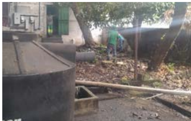
Limpieza de Patio de Zona No.2 - Carrasquilla
