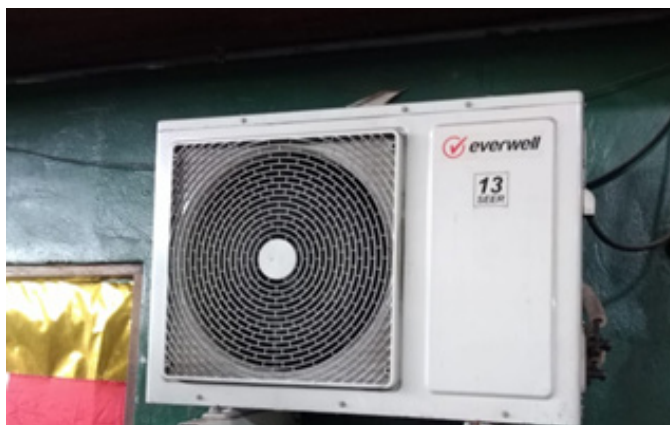
Mantenimiento Preventivo Aire Acondicionado en Zona 1
