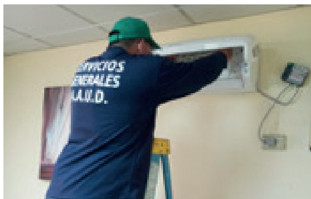
Limpieza de Aires Acondicionados.
