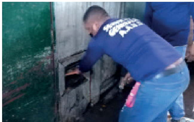
Cambio de tuberías en Zona A – Pacífico.
