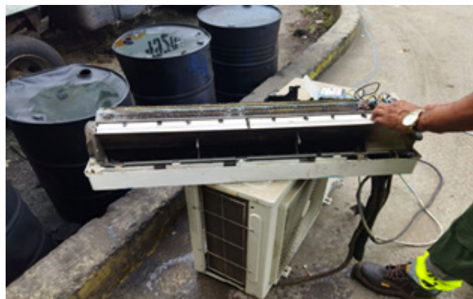
Mantenimiento preventivo de aire acondicionado Zona D – Patacón
