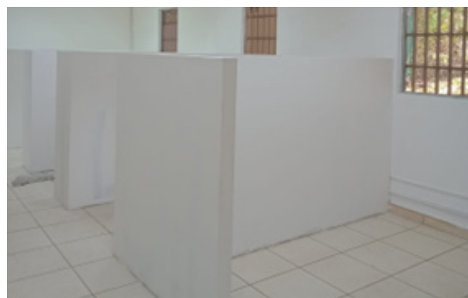
Pintura de Oficinas de Zona No.3 – Relleno Sanitario de Cerro Patacón.
