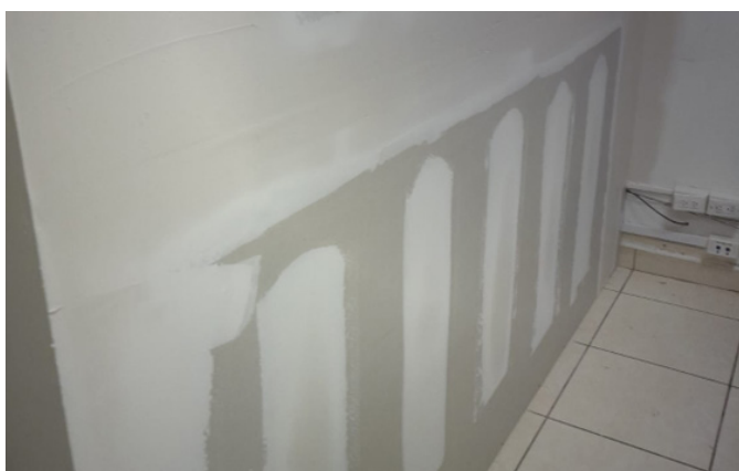
Trabajos de división de gypsum en Zona D - Patacón, nuevas oficinas
