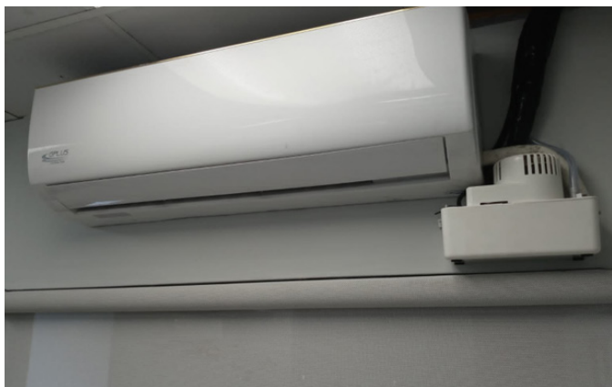
Instalación de aire acondicionado en la oficina de Secretaría General en el PH - Calidonia
