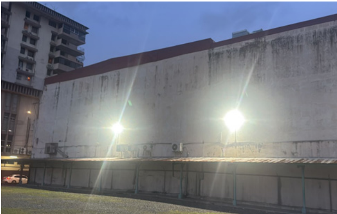
Iluminación de los estacionamientos del PH – Calidonia
