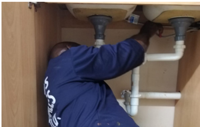
Reparación de la tubería del fregador de la cocina del PH- Calidonia
