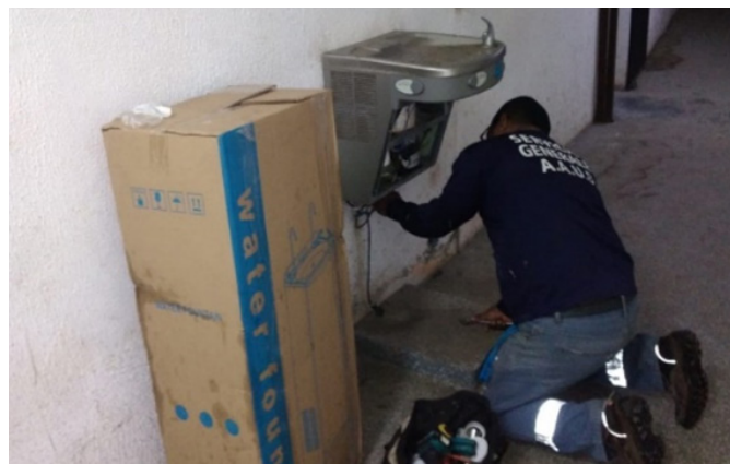
Instalación de nuevas fuentes de agua en Zona No.1 – INADEH.
