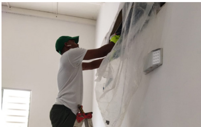
Mantenimiento preventivo de aire Acondicionado en la Base de Curundú
