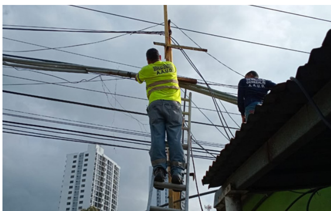
Instalación de luminarias en Zona No.2 - Carrasquilla
