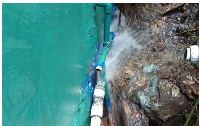
Reparación de tubería de 3/4" de la bomba de succión que abastece la oficina de Patacón
