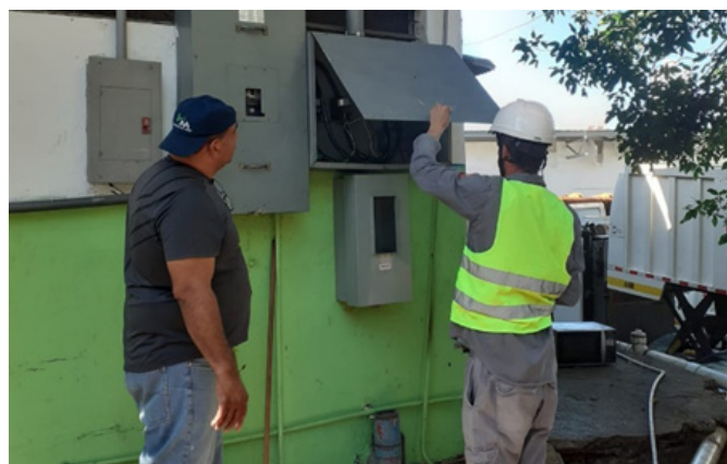
Inspección de Acometida por parte de la Empresa Eléctrica
