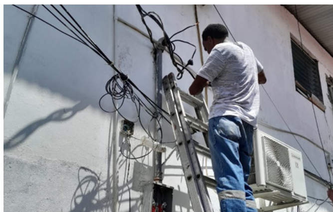
Trabajo eléctrico en Altamira, reparación y restablecimiento de energía eléctrica.
