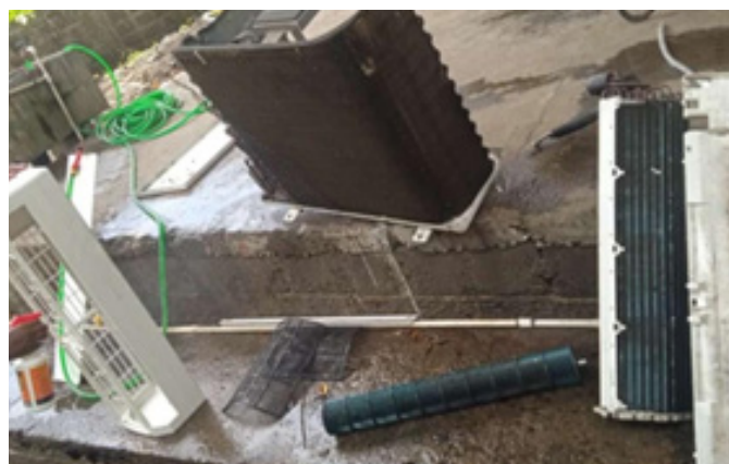
Mantenimiento Preventivo de Aire Acondicionado de Zona 2 – Carrasquilla.
