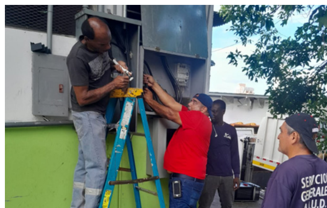
Trabajo de Soldadura para Instalación de Panel para cambio de acometida
