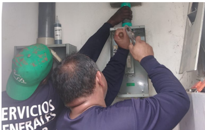
Instalación de cajilla eléctrica, para Breaker Monofásico y tipo de entrada para compensación y distribución de sobrecarga eléctrica.
