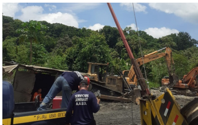
Reparación de Brazo Mecánico para acceso al vertedero
