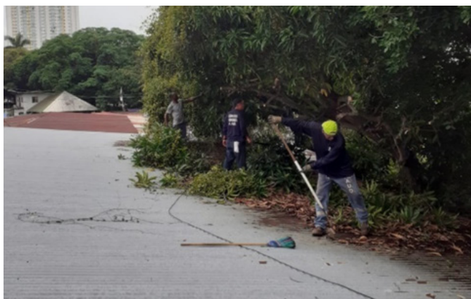
Raleo de árboles, reparación y limpieza de techos en Zona 2 - Carrasquilla
