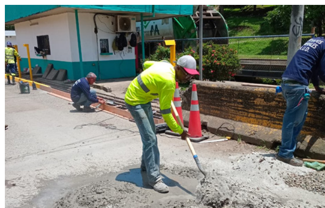
Reparación y mantenimiento de las pesas de Zona No.3 de Cerro Patacón.
