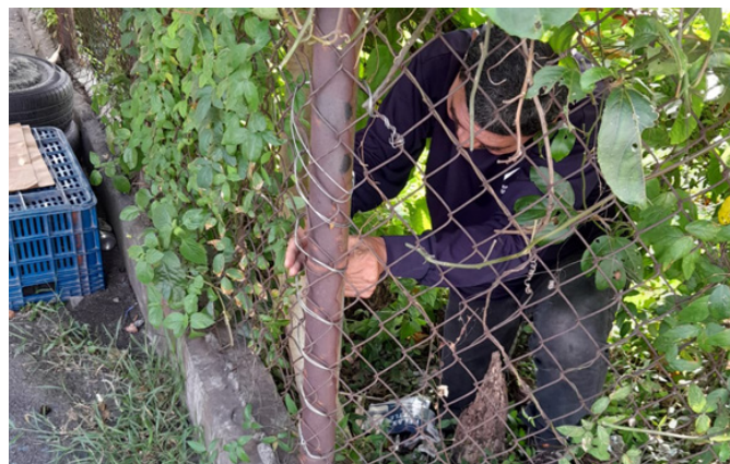
Reparación de Cerca Perimetral en el PH – Calidonia.
