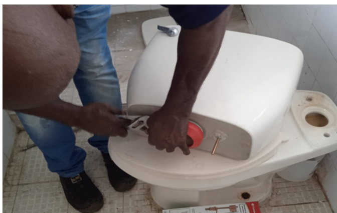
Instalación de lavamanos e Inodoros en Zona No.3 - INADEH
