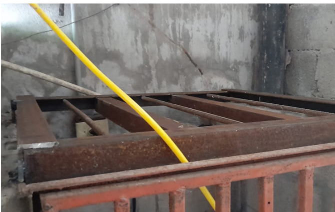
Confección de reja para proteger el compresor de Odontología en la Clínica del Empleado de la AAUD en Zona 2 - Carrasquilla
