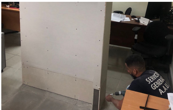
Instalación de divisiones de Gypsum, en Depto. d9e Servicios Técnico
