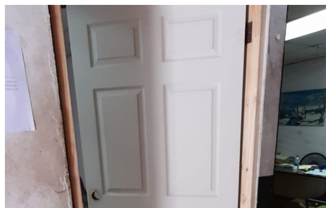
Instalación de puerta en el Departamento de Recursos Humanos en Zona No.1 - Pacífico
