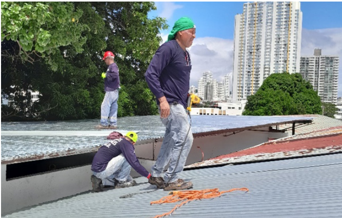
Cambio e instalación de hojas de Zinc, en el Departamento de Fomento a la Cultura en Zona 1 – Carrasquilla.
