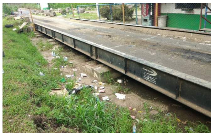
Limpieza de la Pesa No.2
