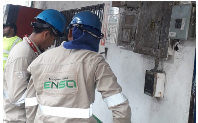
Reparación de panel principal en Zona D – Patacón en conjunto con compañía Eléctrica.
