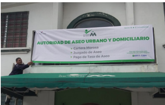
Reparación de Letrero en Altamira
