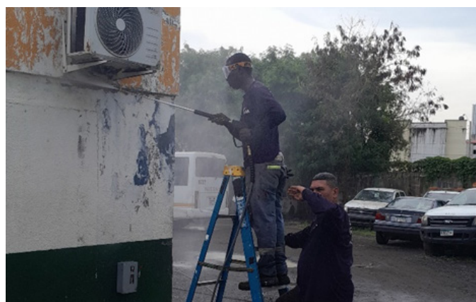
Limpeza de los edificios de Zona No.1 – INADEH, con Hidro Lavadoras
