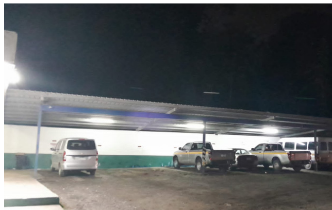
Instalación de luminarias en Zona No.3 – Relleno Sanitario de Cerro Patacón
