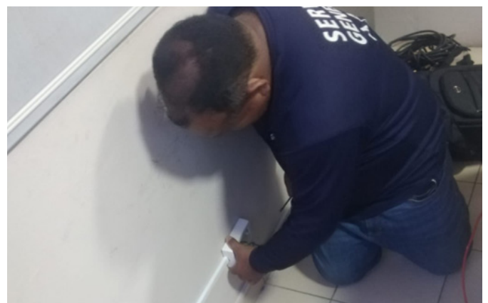
Instalación de tomacorriente e instalación de tubos de 32 wats, en Oficina del PH – Calidonia.
