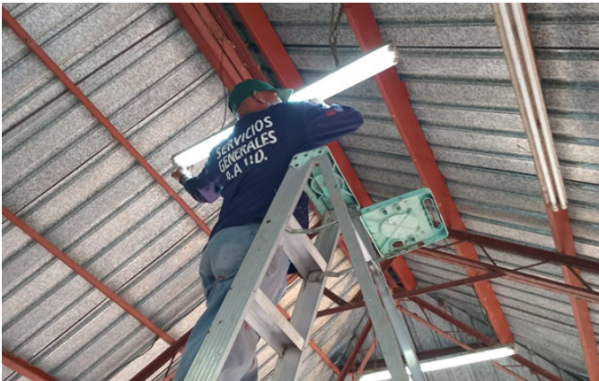
Instalación de luminarias en el Taller de Vulcanización en Zona No.2 – Carrasquilla, al igual que la iluminación del rancho.
