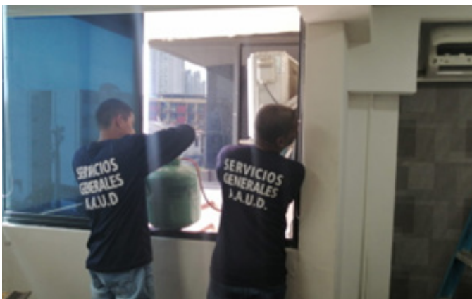
Mantenimiento Preventivo de Aire Acondicionado de la Dirección Administrativa
