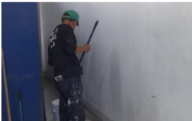
Pintura de los vestidores de Zona No.3 – Relleno Sanitario de Cerro Patacón
