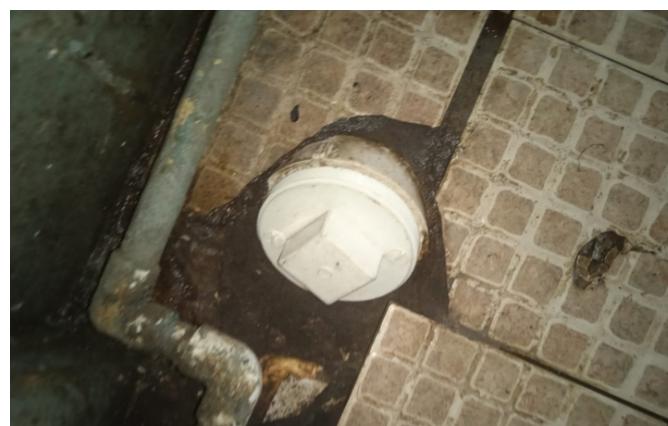
Reparación de Registro en Zona 1 Base de Curundu
