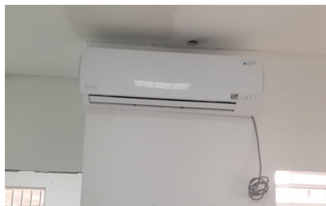
Instalación de aires acondicionados en Zona No.3 – Relleno Sanitario de Cerro Patacón
