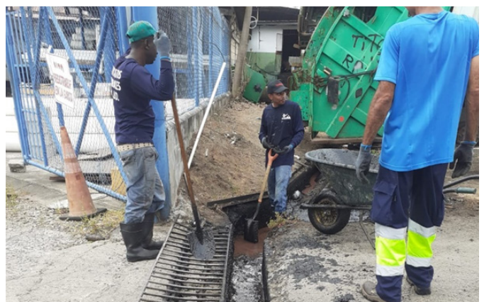
Trabajo de limpieza de cunetas en Zona B – Carrasquilla.
