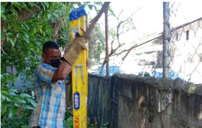
Instalación de Serpentina en el muro perimetral de Zona No.2 - Carrasquilla
