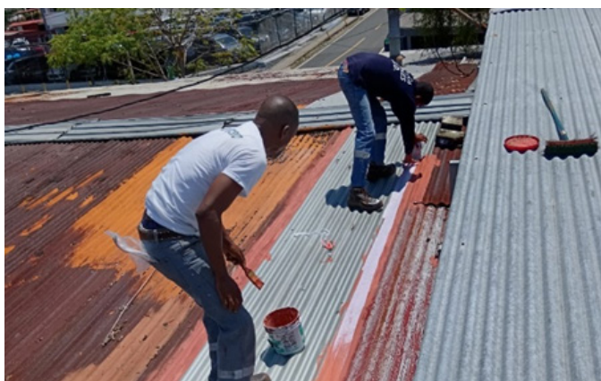
Mantenimiento preventivo anti gotera en Zona No.2 – Carrasquilla, Departamento de Seguridad
