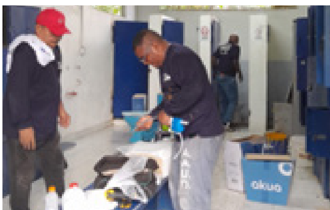
Instalación de inodoros y lava mano, en los baños de Zona No.3 – Relleno Sanitario de Cerro Patacón
