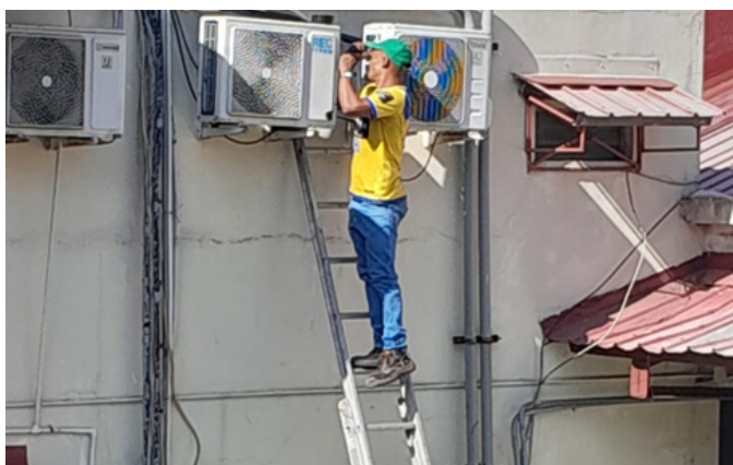
Reparación de aire Acondicionado en el PH - Calidonia
