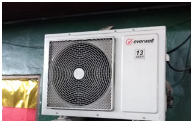
Mantenimiento Preventivo Aire Acondicionado en Zona 1
