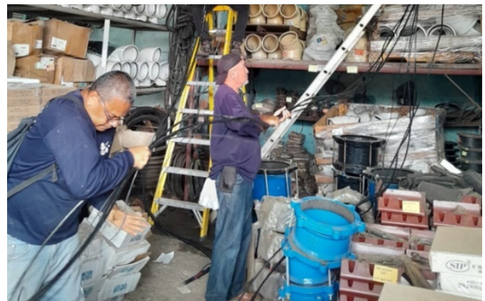
Reparación de acometida del IDAAN que suministra energía eléctrica a la AAUD
