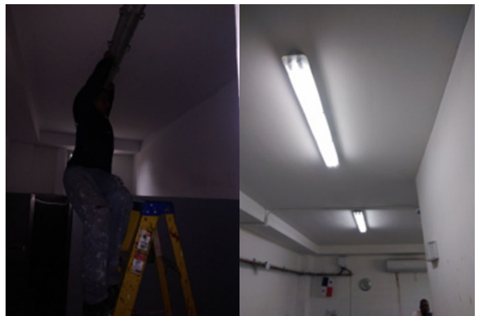
Reparación de lámparas en la Base de Curundú
