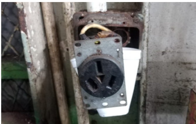
Reparación de tomacorriente 220 en el Taller de Soldadura de Zona1 Pacífico.
