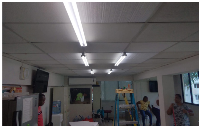
Instalación de lámpara para iluminación de la Cafetería en el PH - Calidonia
