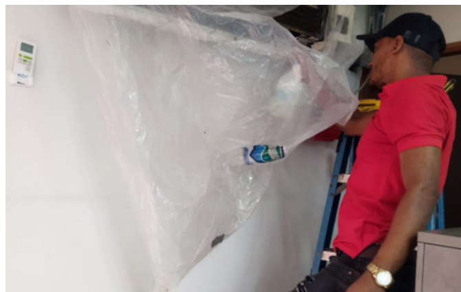
Mantenimiento Preventivo de Aire Acondicionado del PH - Calidonia
