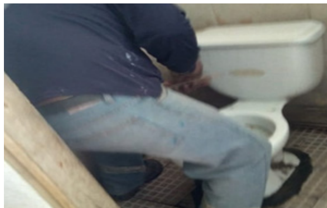
Instalación de Inodoros
