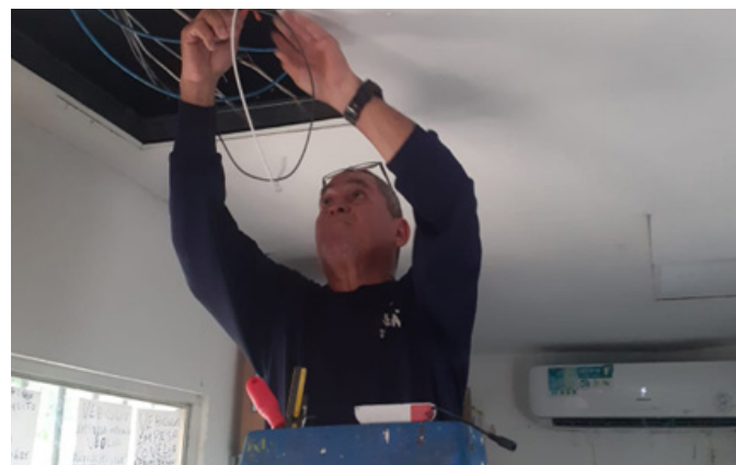
Reparación de luminarias en la Pesa en Zona D – Patacón
