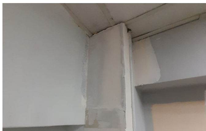
Reparación de Pared de gypsum en la Oficina de la Secretaría General en el PH - Calidonia
