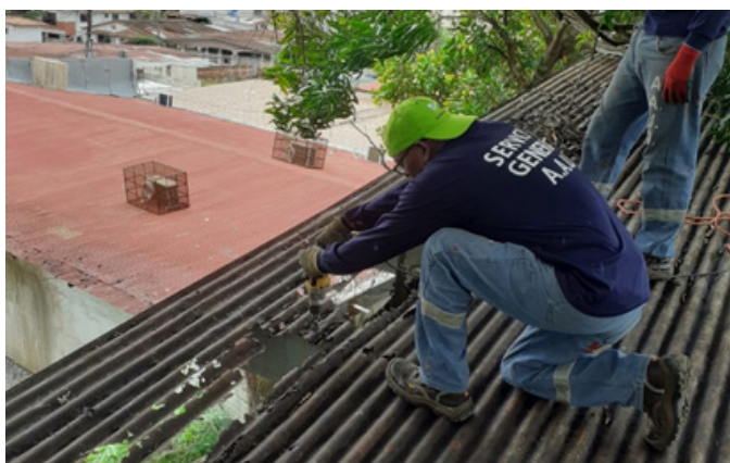
Limpieza de techo Zona 2 - Carrasquilla
