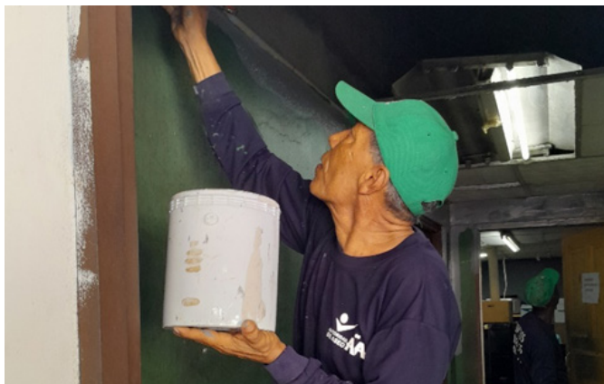
Pintura del Departamento de Atención Inmediata (311) en Zona 2 - Carrasquilla
