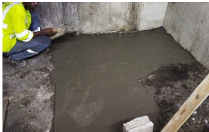
Reparación del piso del Restaurante
