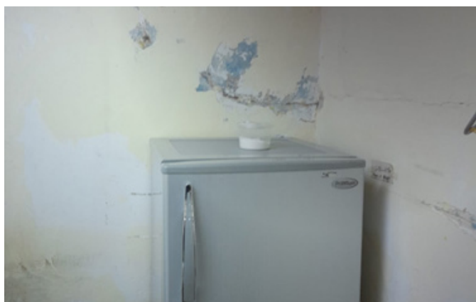
Reparación de paredes en Altamira
