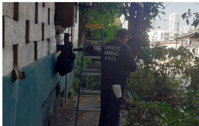
Reparación de panel eléctrico en Zona D - Patacón
