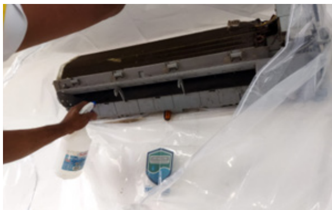
Mantenimiento Preventivo de Aire Acondicionado en Zona 1 Base de Curundú
