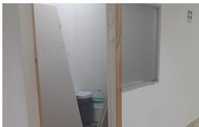
Instalación de puerta en Zona No.3 – Relleno Sanitario de Cerro Patacón
