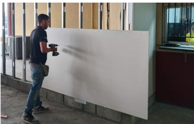
Construcción de estructura para cuarto de máquinas de aire acondicionado en el PH – Calidonia, al lado del Depto. de Tesorería.
