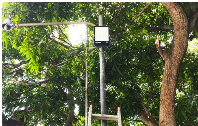
Instalación de lámparas en Zona No.2 - Carrasquilla
