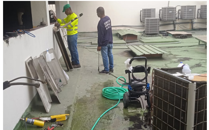
Limpeza y mantenimiento de aires acondicionados en el PH – Calidonia.
