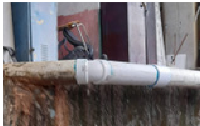
Reparación de Tuberías de Aguas Negras Zona B – Carrasquilla
