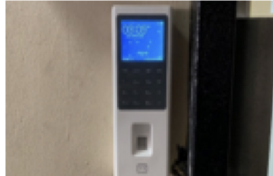
Instalación de dispositivo de acceso en el Departamento de Tesorería
