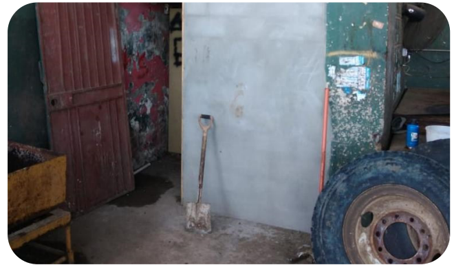
Reparación de pared en depósito de Taller de Chapistería.
