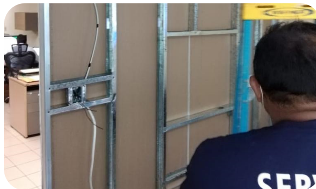
Instalación de gypsum en el Departamento de Servicios Técnicos
