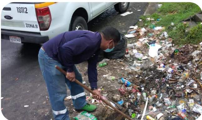
Reparación de tubería por daño de camión compactador en Pueblo Nuevo.
