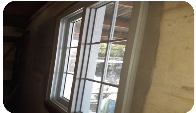
Remodelación de las ventanas del Depósito de útiles de oficina
