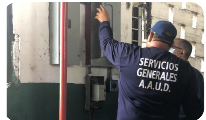
Cambio de Breakers en el Taller de Chapistería y revisión de panel eléctrico en Carrasquilla.
